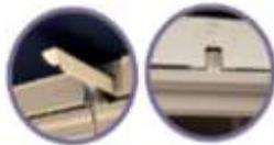
La unión entre los perfiles de aluminio se realiza sin componentes intermedios y al recaer el peso en la parte inferior, dota al sistema de una mayor estanqueidad.
